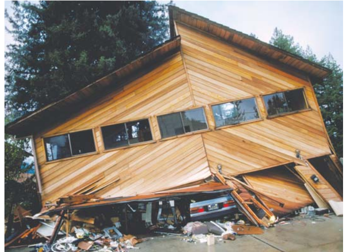
Esta casa en las montañas de Santa Cruz se derrumbó en el terremoto de Loma Prieta que alcanzó una magnitud de 6.9. (Foto USGS)
